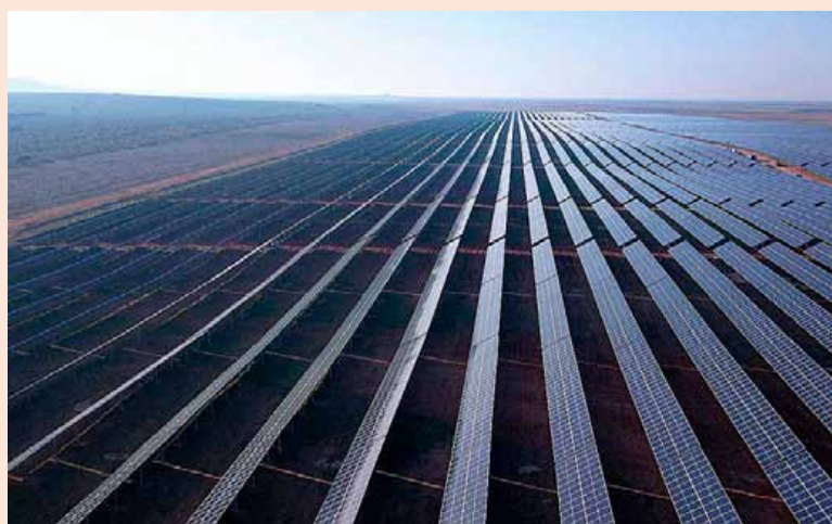
La nueva planta contará con una superficie de 290 hectáreas y será la más grande de la energética en España. En la imagen, la planta fotovoltaica de Naturgy El Carpio (Toledo).
