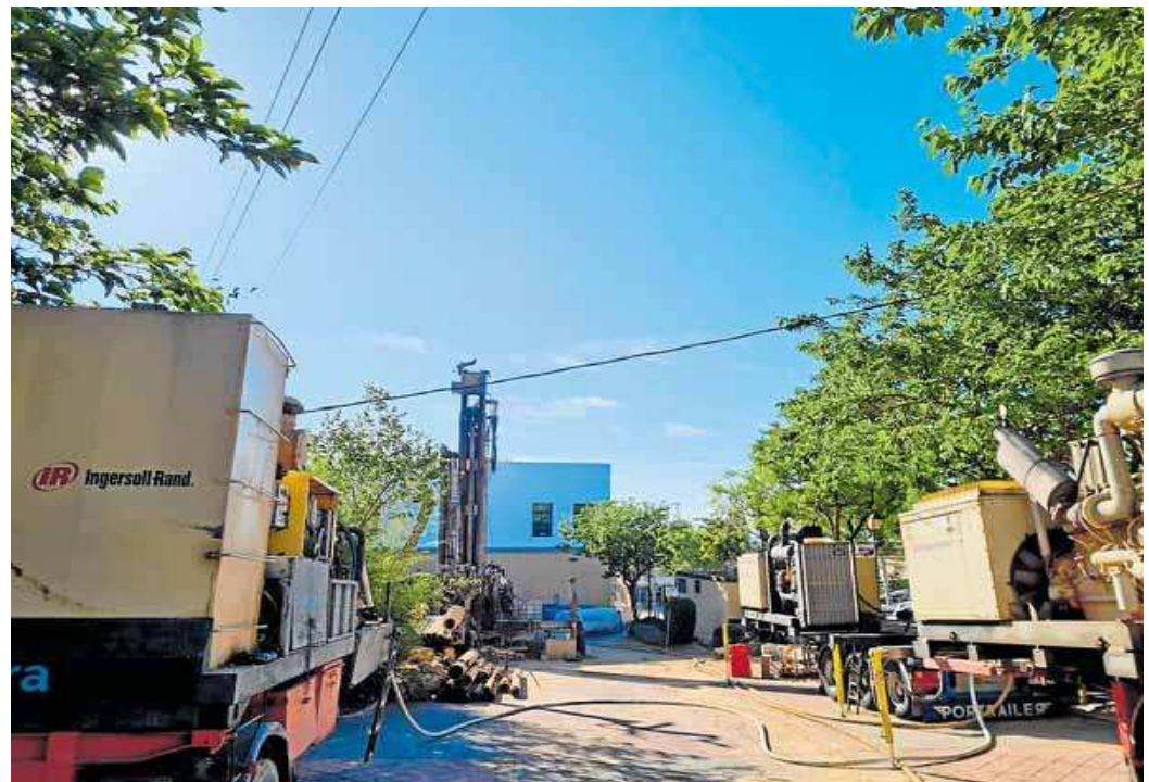
Obras en el sondeo de El Saltillo, en Arroyo de la Miel. L. CÁDIZ
