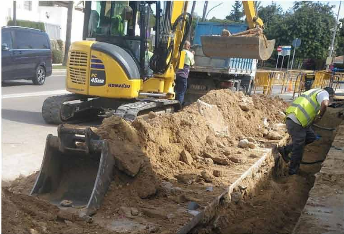
Obras en Vistahermosa
