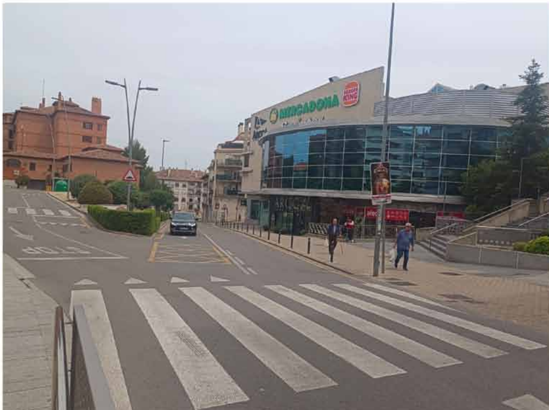
El paseo del Mercadal en la zona del Arcca y comienzo de avenida de la Estación ha sufrido varios reventones de tuberías de la red de abastecimiento de agua
