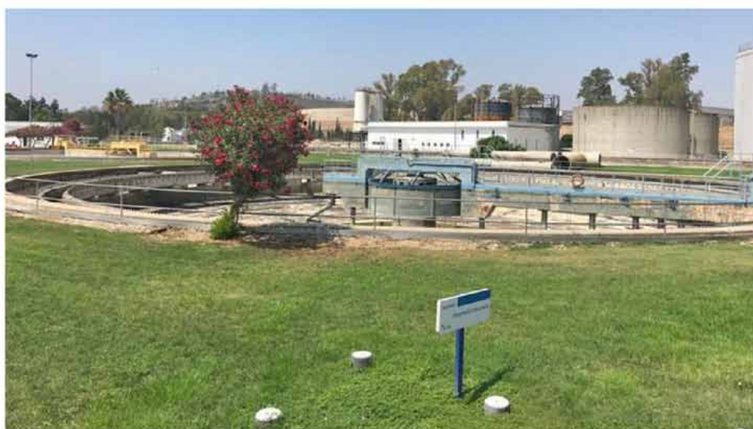
Imagen de la Depuradora de Aguas Residuales Guadalete de Jerez.
