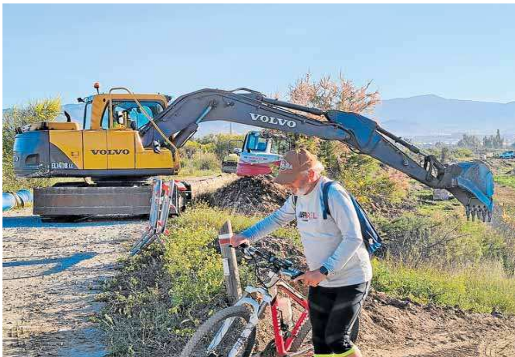
Un ciclista pasa junto a las máquinas que ejecutan la obra, en una imagen de abril, en Zapata. J. R. C.
