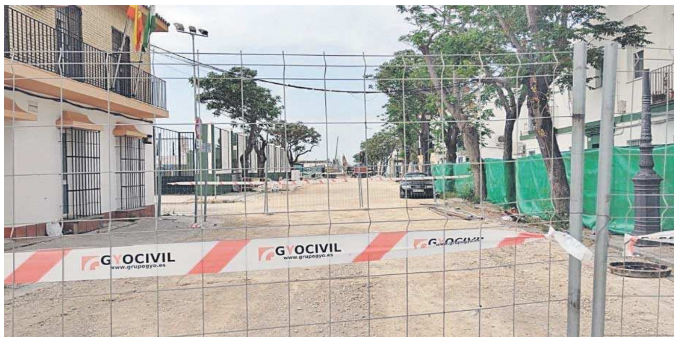
Una imagen de la obra del tanque de tormentas, en la avenida de la Bajamar.
